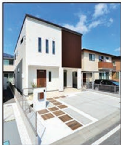
【当社施工事例】
