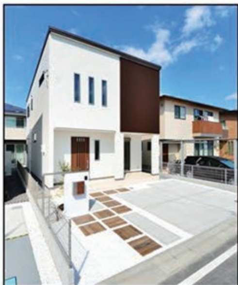
【当社施工事例】
